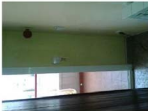
Fotografía : Vista Acceso Galería
